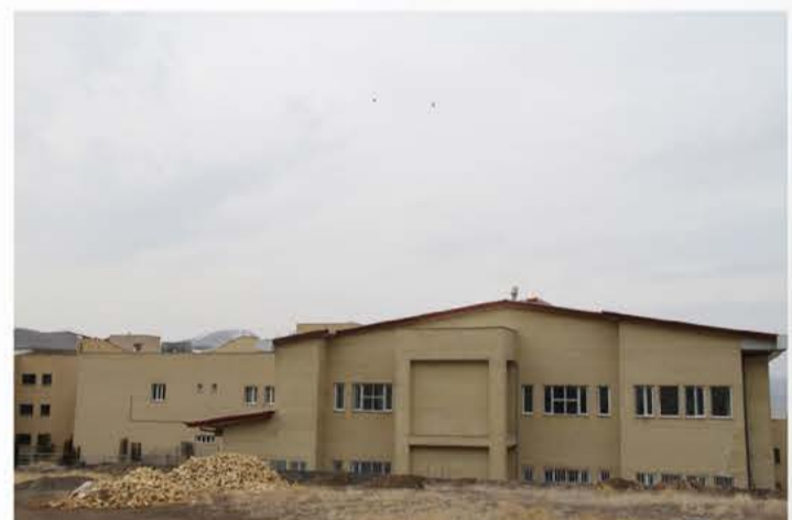
ساختمان آزمایشگاه مرکزی مساحت: ۲۰۰۰ متر مربع سال شروع: ۱۳۹۴ سال پایان: ۱۳۹۸
